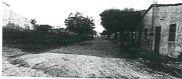
Vista da Rua Sebastião Lopes Ribeiro
